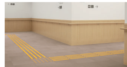
警告(イエロー)・誘導(イエロー)使用
