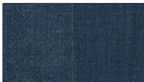
4400 ↑ジョイント部拡大写真
